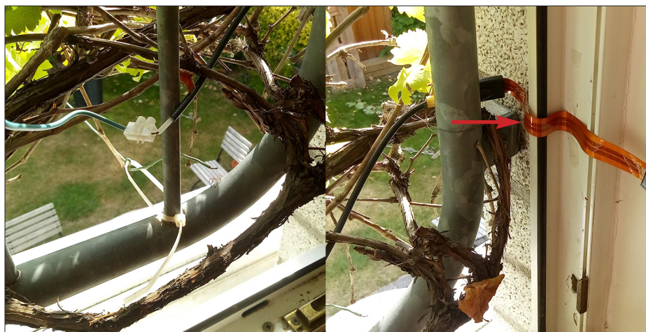
Bild E1: Fensterdurchführung des Antennenkabels
