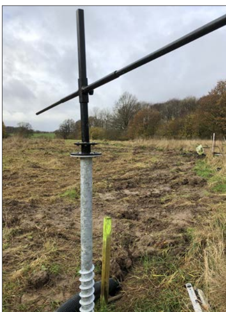
Schraubfundament während des Eindrehens in den Erdboden
