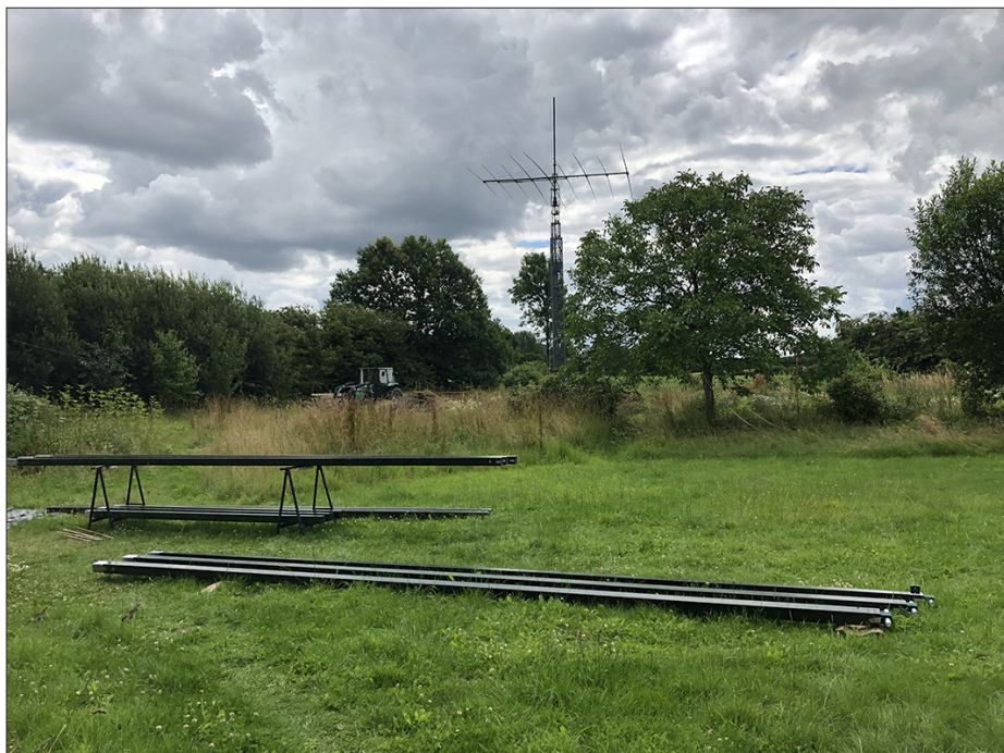
Maste für eine 4-Square während des Aufbaus
