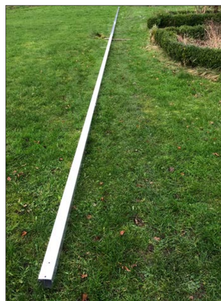
21-m-langes Strahlerelement mit untergelegten Holzklötzen während der Montage
